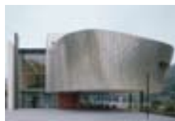
Дом на реке, Ебербах/ Некар, D Dipl.-Ing. Günter Hermann, Штутгарт Güther GmbH, Фойхтванген TECU® Олово
