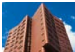
Офицерские квартиры Королевских Военно-Морских Сил, Ден Хельден, NL Van Herk & de Kleijn Architecten BV, Амстердам Ridder BV, Хорн TECU® Классика
