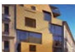
Жилой дом с офисными помещениями, Грац, A INNOCAD Planung und Projektmanagement GmbH, Грац Steinbauer, Юденбург TECU® Золото
