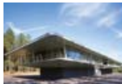
Центр управления движением, Вольфхезе, NL De Architecten Cie, Амстердам Verkoelen Dakbedekkingen BV, Бигден TECU® Олово
