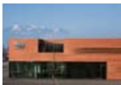
Офисно-производственное здание, Коблах, A AIX Architects, Фельдкирх Peter GesMBH + CoKG, Коблах TECU® Классика
