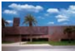
Мемориальный музей Де Йонг, Сан-Франциско, USA Herzog & de Meuron Architekten, Базель, CH A. Zahner Co. Architectural Metals, Канзас Сити TECU® Классика
