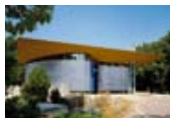
Церковь Св. Марии, Роттердам, NL Mecanoo architecten, Дельфт Leidekkersbedrijf Jobse BV, Миддельбург TECU® Олово
