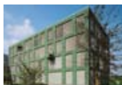
Инновационный центр Вольфсбург АГ, Вольфсбург, D O.M. Architekten BDA, Брауншвайг Bisping GmbH & Co., Мюнстер TECU® Сетка Патина
