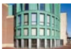
„Boscotondo“, Хельмонд, NL Adolfo Natalini Architetti, Флоренция Architectenburo C. Schrauwen, Амстердам Crombach Dakafwerking BV, Wittem TECU® Патина
